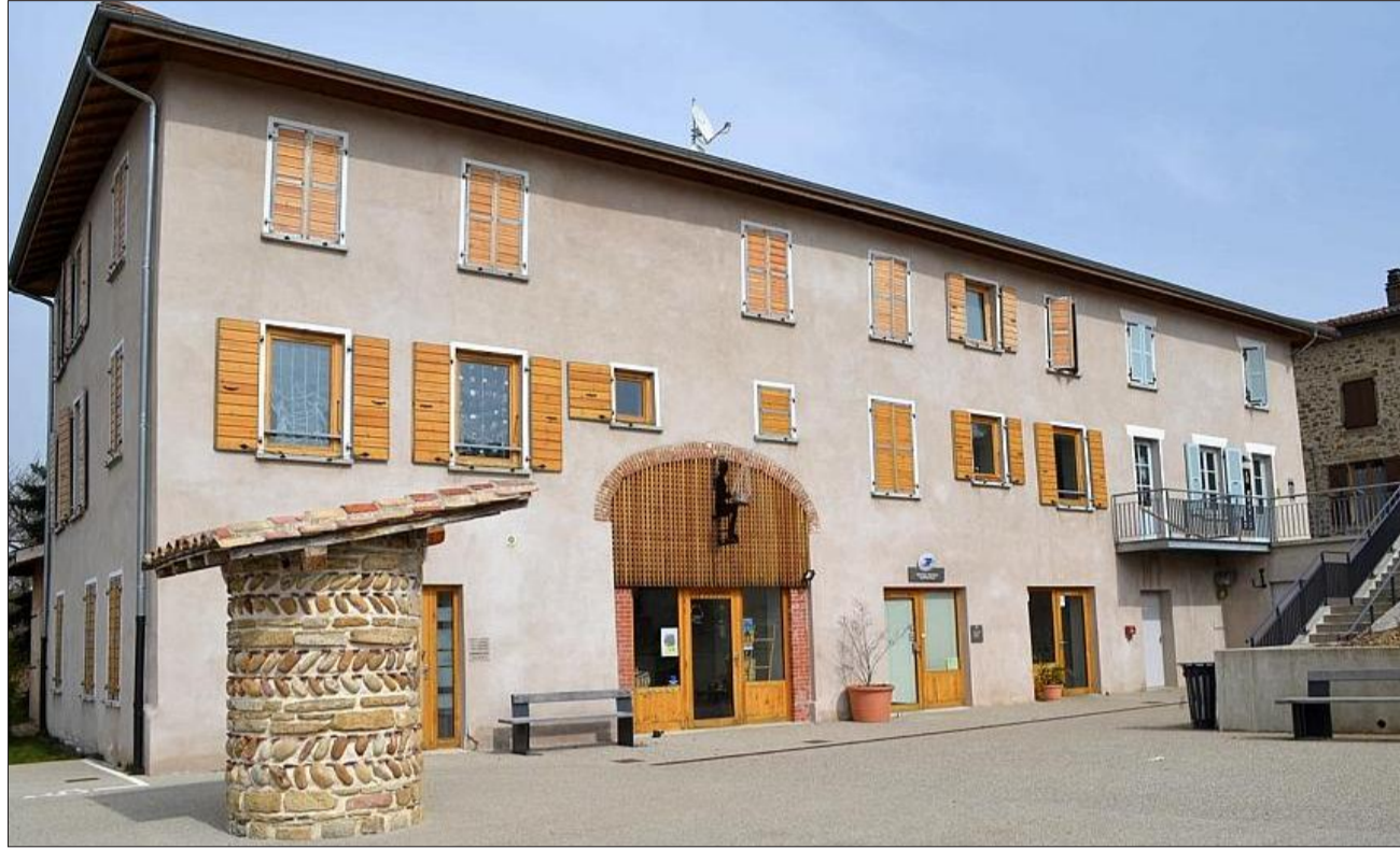
Cet ancien corps de ferme en pisé aujourd'hui restauré, au cœur du village de Montseveroux, est une belle démonstration du savoir-faire des membres de l'association Tera, qui a assuré la maîtrise d'ouvrage du chantier. Photos Le DL/A.L.-V.
