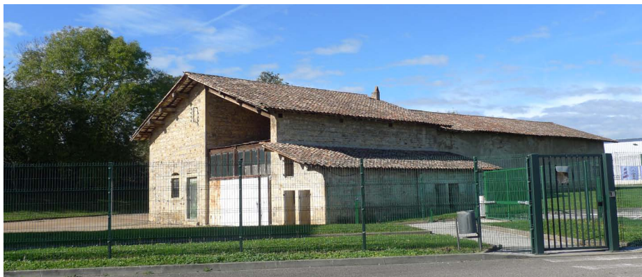
▲ Vue du bâtiment existant
