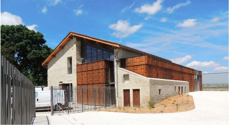
▲ Photo extérieure du bâtiment.
