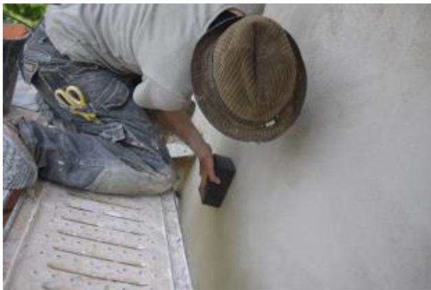
de réaliser la finition en 2 passes à frais augmente l'ouvrabilité et permet de maîtriser d'avantage l'aspect de la couche finale. Elle a ici été réalisée avec un sable local de granulométrie 0/2. La finition a été adoucie à l'éponge afin d'estomper les marques de talochage et les raccords.
