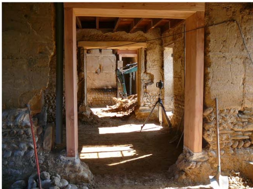
PHOTOS DU CHANTIER
